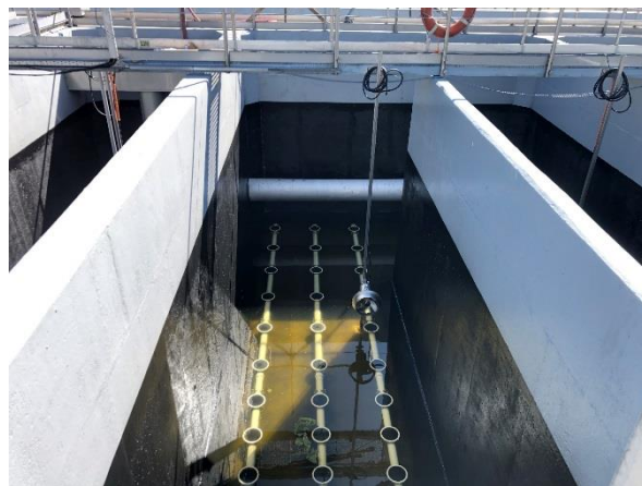
Fot.2. Modernizacja reaktorów biologicznych
