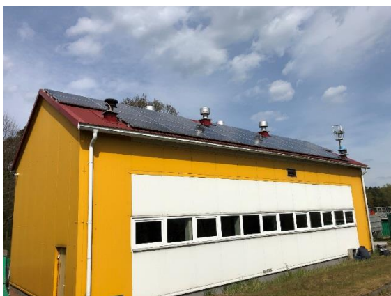
Fot. 11. Instalacja fotowoltaiczna na dachu wiaty kratopiaskownika
