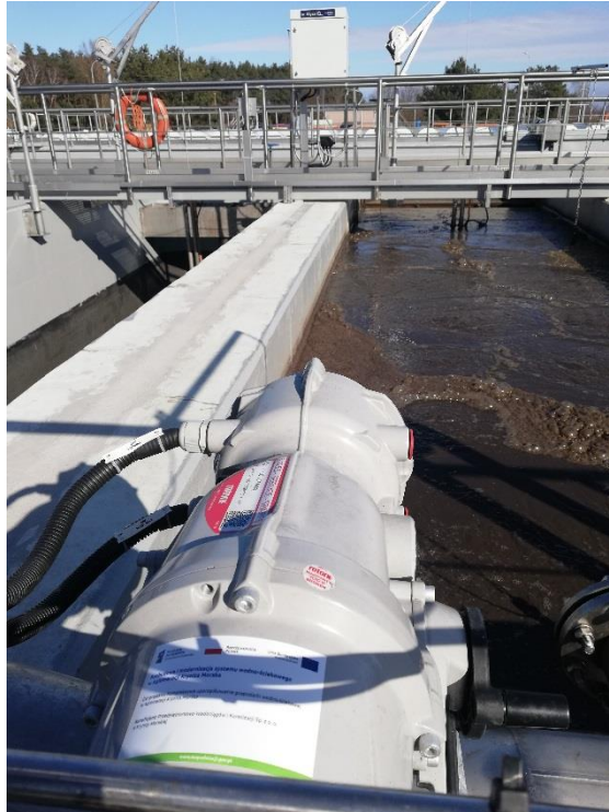
Fot.3. Modernizacja reaktorów biologicznych
