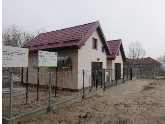
Fot. 20. Rozbudowa istniejącej tłoczni w Piaskach
