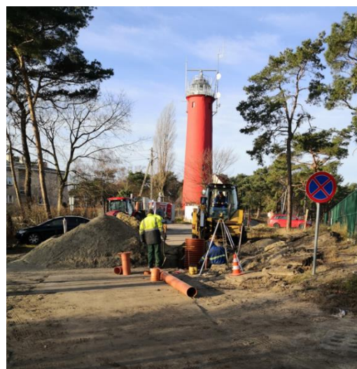
Fot. 19. Rozbudowa kanalizacji sanitarnej w ulicy Żołnierzy
