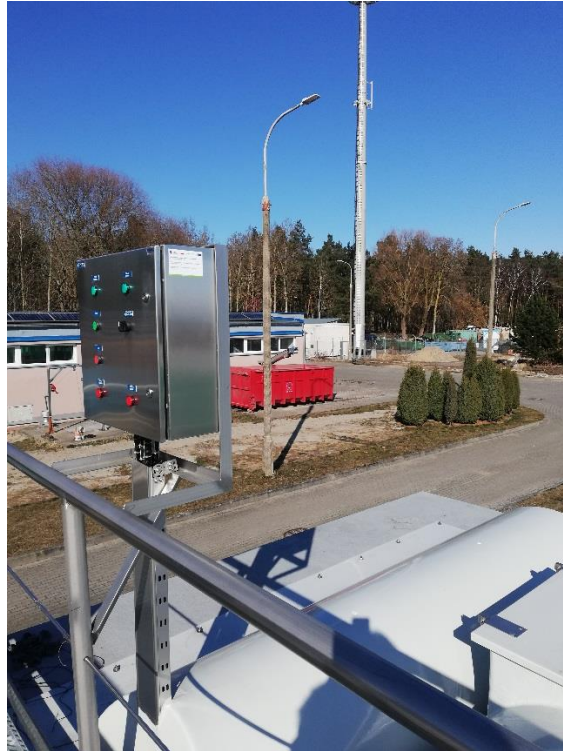
Fot. 5. Modernizacja reaktorów biologicznych
