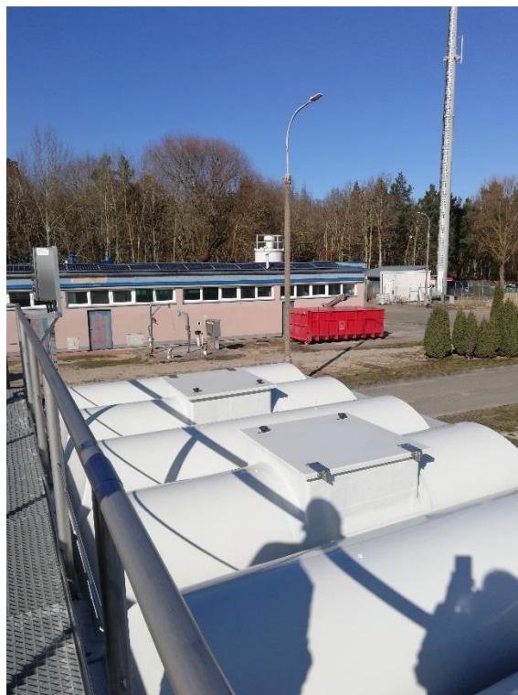
Fot. 4. Modernizacja reaktorów biologicznych
