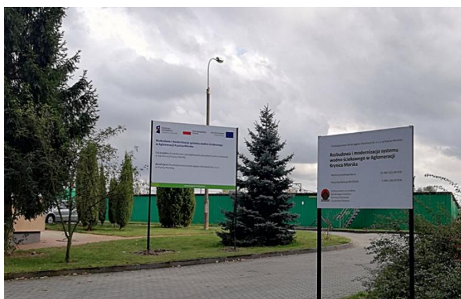
Fot. 1. Oczyszczalnia ścieków w Krynicy Morskiej
