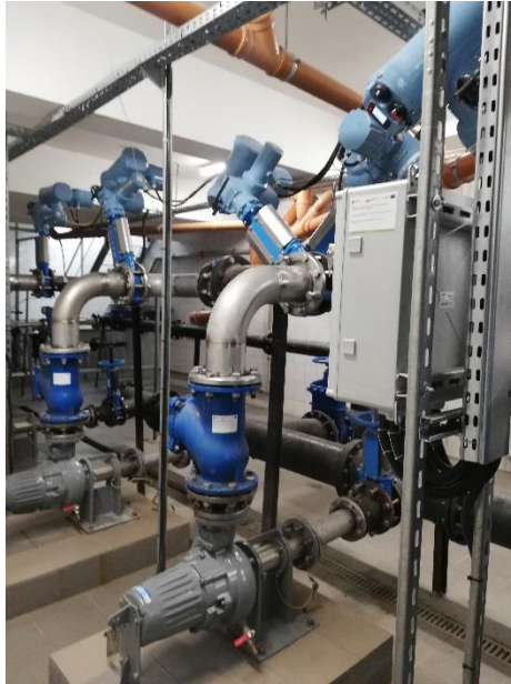
Fot.9. Modernizacja systemu napowietrzania
